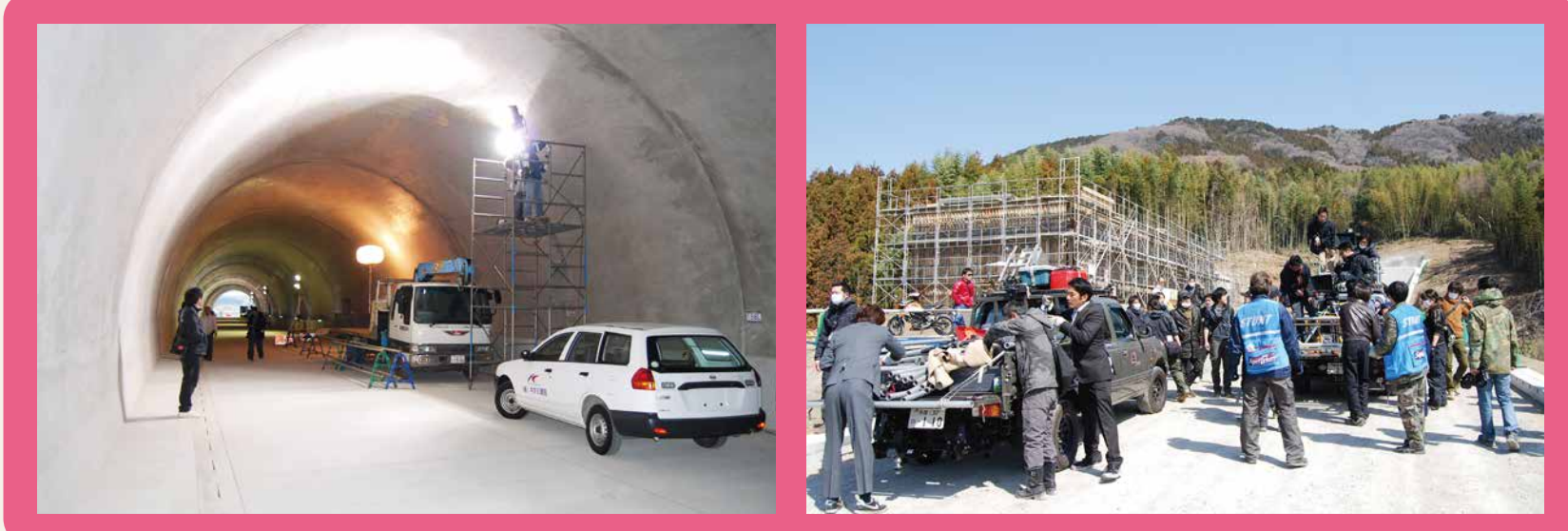
朝日トンネル
