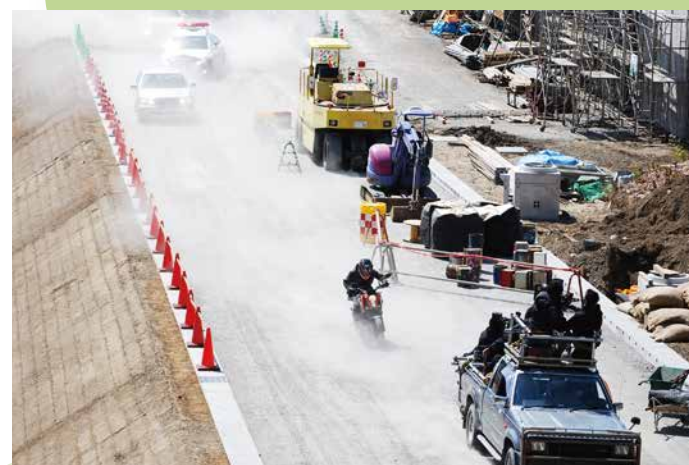
朝日トンネル
