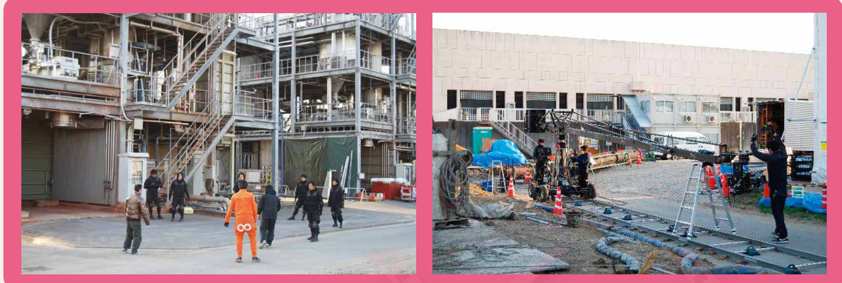
霞ヶ浦浄化センター
