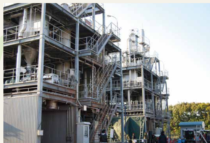
霞ヶ浦浄化センター
